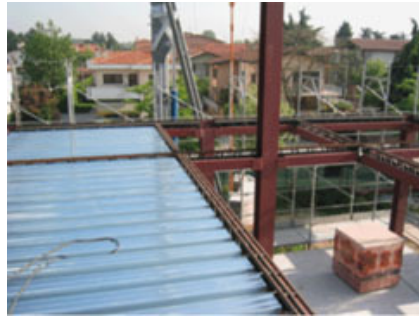
Fig. 7 – Particolare di posa del solaio di lamiera grecata.
