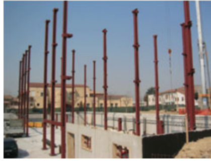
Fig. 5 – Posa dei pilastri in acciaio.
