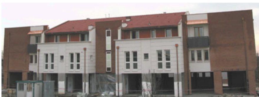
Fig. 1 – Vista generale del fabbricato.
