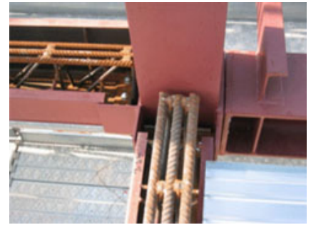
Fig. 14 – Particolare del nodo strutturale.
