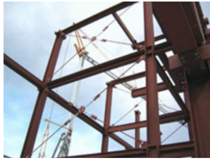
Fig. 10 – Particolare della croce in acciaio per la controventatura del vano scale.
