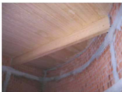
Fig. 10 – Particolare della parete perimetrale curva in fase di realizzazione.
