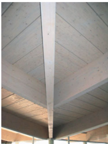
Fig. 13 – La copertura in corrispondenza della trave diagonale a lavori ultimati.
