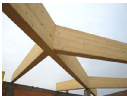
Fig. 12 – La trave diagonale in fase di posa.
