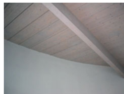
Fig. 11 – Particolare della parete perimetrale curva a lavori ultimati.
