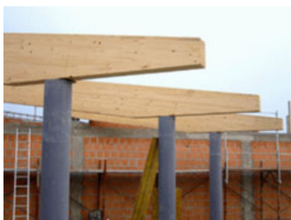
Fig. 9 – Particolare dell'appoggio delle travi sui pilastri.
