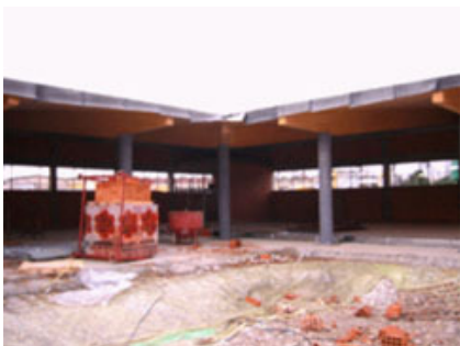
Fig. 6 – Fase di realizzazione del parterre in legno che si affaccia sulla corte interna.
