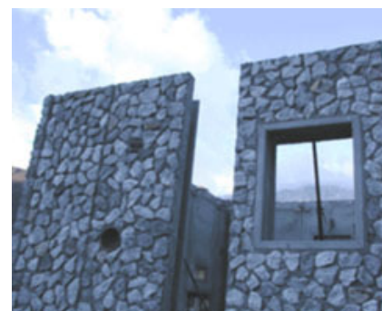
Fig. 12 – Particolare della posa dei pannelli.
