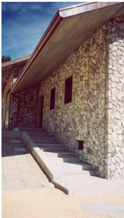
Fig. 6 – Particolare di una fiancata del fabbricato. Si noti come la pianta dell'edificio sia tale da definire due zone distinte.
