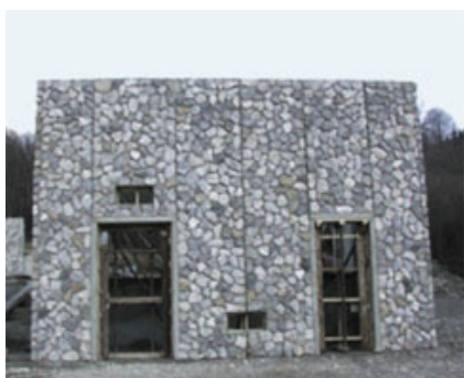
Fig. 10 – Posa dei pannelli che contribuiscono a formare i fori porta.
