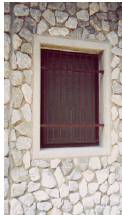
Fig. 8 – Particolare di un infisso completamente realizzato in un pannello doppia lastra.
