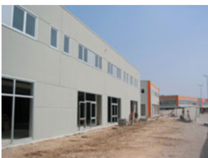
Fig. 7 – I pannelli di tamponamento e gli infissi.
