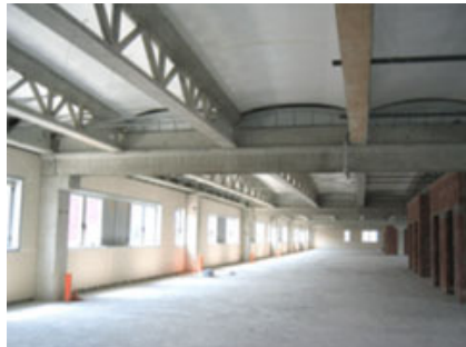
Fig. 4 – Vista dell'interno del fabbricato B.
