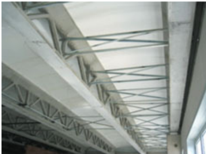
Fig. 3 – Particolare della trave reticolare.
