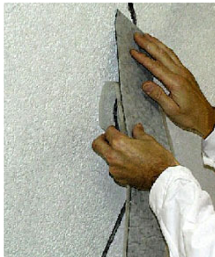
Fig. 9 – Applicazione striscia in resina butilica.
