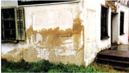
Fig. 3.3 – Umidità per pressione idrostatica.
