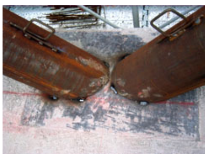
Posizionamento dei puntoni e temporaneo fissaggio alla piastra di base con saldature per il posizionamento.
