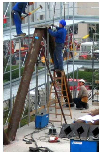
Regolarizzazione delle quote d'imposta delle piastre di sommità.
