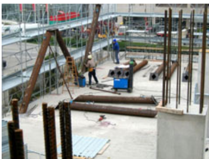
Immagine generale del montaggio dei puntoni.
