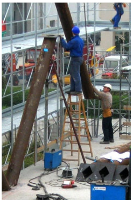
Posizionamento del secondo puntone.
