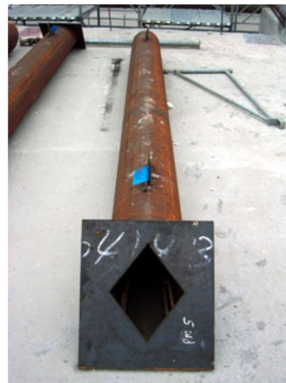
L'elemento in acciaio una volta scaricato a terra in cantiere. In evidenza la piastra di sommità.
