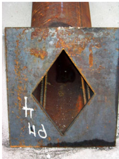
Sezioni terminali dei puntoni in acciaio. A sinistra la sezione alla base (che poi andrà connessa alla piastra annegata nel solaio), a destra la sezione di sommità in cui la piastra è già stata connessa in fase di produzione.
