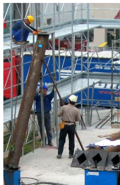
Posizionamento del puntello tiraspingi per regolare l'inclinazione del puntone.
