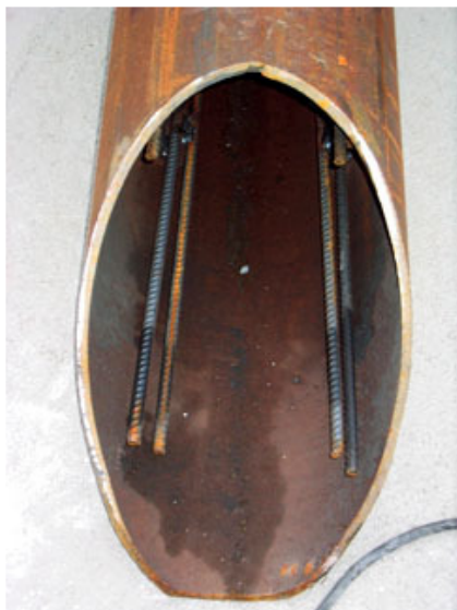
Sezioni terminali dei puntoni in acciaio. A sinistra la sezione alla base (che poi andrà connessa alla piastra annegata nel solaio), a destra la sezione di sommità in cui la piastra è già stata connessa in fase di produzione.
