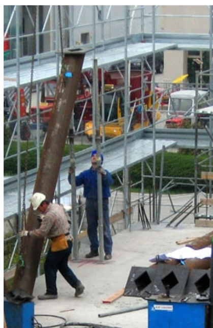
Posizionamento dei puntelli e inserimento del puntone nelle chiamate.
