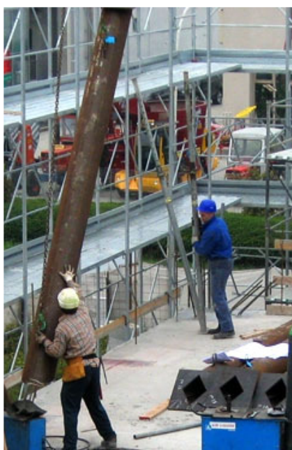
Posizionamento del puntone in corrispondenza delle chiamate.
