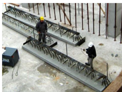
Fase di installazione della linea vita su trave TLQ. Nella figura a sinistra è visibile l'inserimento della fune, mentre la figura a destra illustra la fase di tenditura della stessa.
