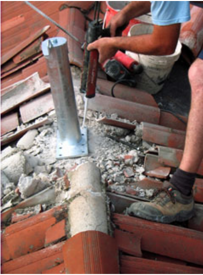
Installazione dei paletti e del cordino di acciaio.
