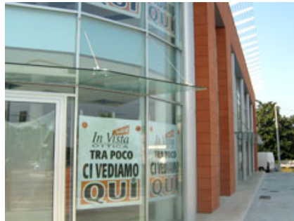
Fig. 19 - Particolare delle pensiline in acciaio e vetro.
