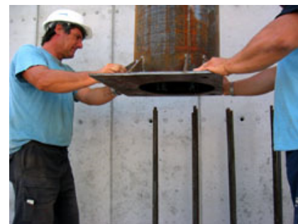
Fig. 8 - Fase di posa del pilastro.
