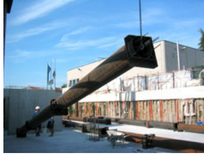
Figg. 12-13-14 - Fasi di movimentazione e posa dei pilastri in acciaio pluripiano.
