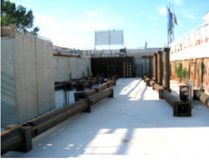
Figg. 12-13-14 - Fasi di movimentazione e posa dei pilastri in acciaio pluripiano.
