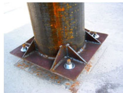
Fig. 8 - Fase di posa del pilastro.
