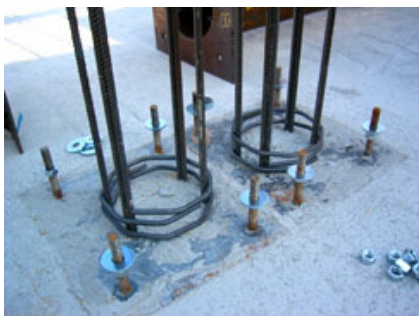
Fig. 6 - Piastra annegata nelle fondazioni con i ferri di ripresa per i pilastri in acciaio.
