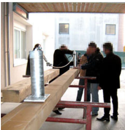
Dimostrazione di montaggio di un sistema anticaduta.
