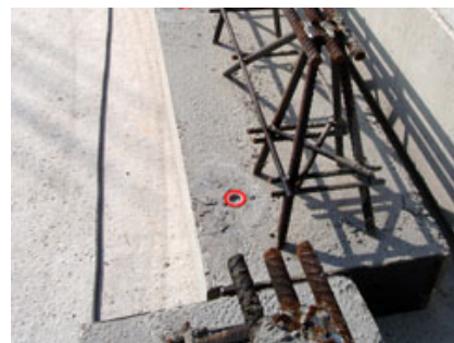
Fig. 15-16 - Boccole annegate nello zoccolo delle travi PREM (anelli di colore rosso).
