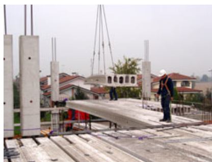
Figg. 5-6 - Particolari di appoggio delle travi PREM ai pilastri BAUTEC pluripiano. Si notino le mensole dei pilastri, già predisposte in fase di produzione.
