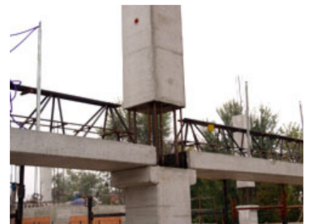
Figg. 5-6 - Particolari di appoggio delle travi PREM ai pilastri BAUTEC pluripiano. Si notino le mensole dei pilastri, già predisposte in fase di produzione.
