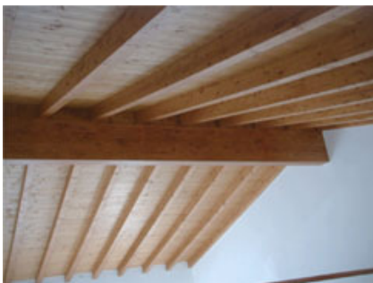
Fig. 2 - Particolare della trave di colmo con vista dell'orditura secondaria perpendicolare.
