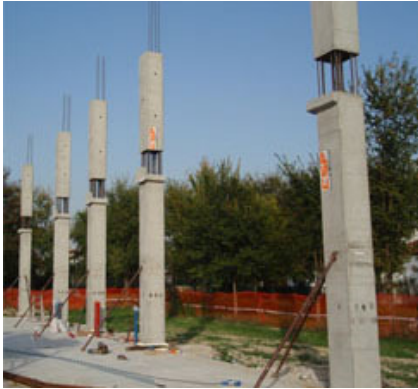
Fig. 5 - Vista del cantiere.
