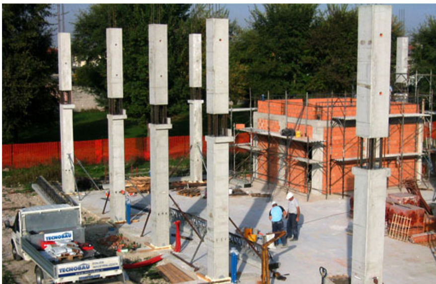
Fig. 1 - Vista del cantiere.
