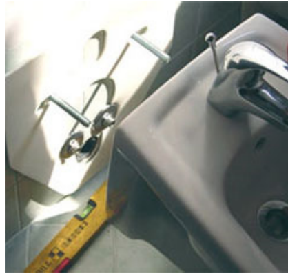
Fig. 6 - Posa del sanitario con elemento separatore.
