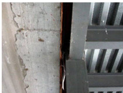
Fig. 7 - Foto del solaio alveolare e del solaio preesistente mantenuto. Come si vede il solaio precedente si regge su travi IPE.
