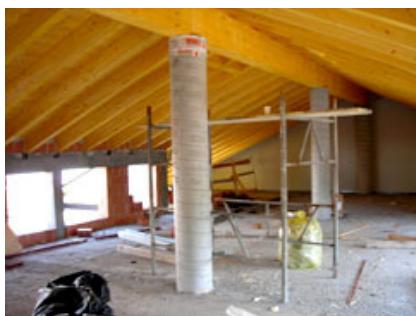
Fig. 8 - Vista interna della copertura. Le gronde centrali dell'edificio sono arretrate rispetto alle pareti perimetrali.
