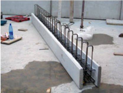
Elemento prefabbricato per realizzazione architrave. La modalità di costruzione e la tecnologia impiegata sono le stesse degli elementi che realizzano le pareti perimetrali. Da notare la gabbia finita.
