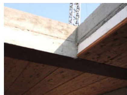
Solaio Evoluzione® posato.
