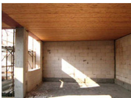
Dettagli dopo l'esecuzione del getto di cls di completamento.
