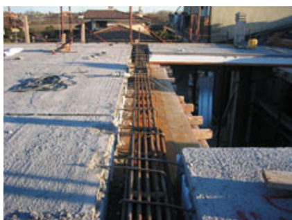
Dettagli di posa del solaio Evoluzione su travi PREM.
