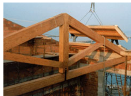
Fig. 4 - In primo piano la capriata in legno lamellare e i pannelli di copertura.
