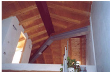
Fig. 6 – Copertura in legno massello delle residenze in doppia altezza.
