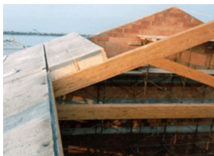
Fig. 3 - Particolare della fase di montaggio.
