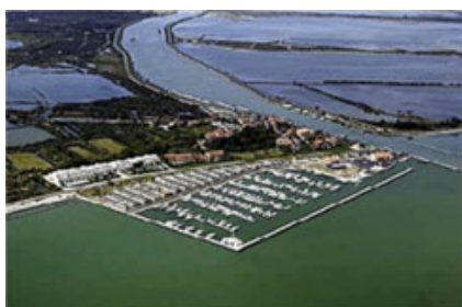
Fig. 1 - Foto aerea dell'area del porto.
