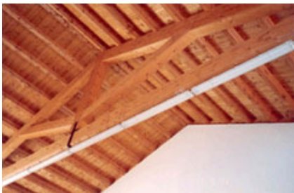
Fig. 5 – Capriate in legno lamellare all'interno degli spazi adibiti a uffici.
