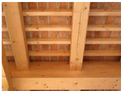
Interno del soffitto del portico (interposto con tavelle).
