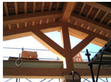
Vista della capriata dall'interno del portico.
