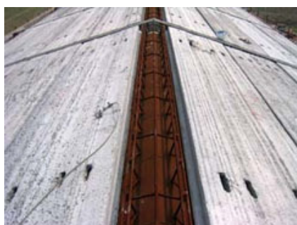
Solaio alveolare posato.
