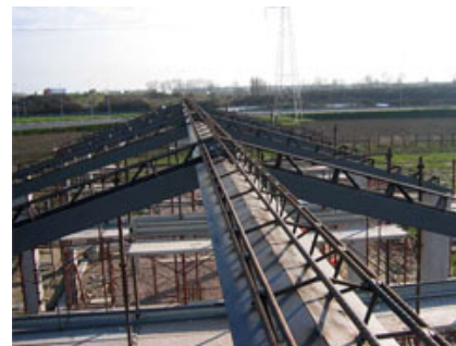
Vista della copertura, con capriate e Travi TMQ di colmo montate.
