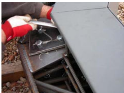
Particolare serraggio della piastra per la giunzione dei puntoni.
