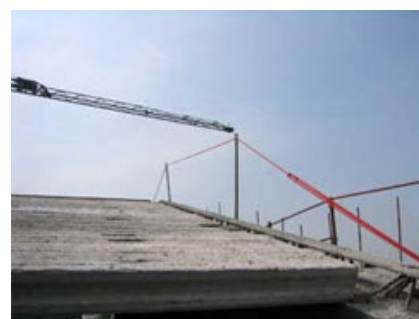
Particolare del sistema di linee-vita.
