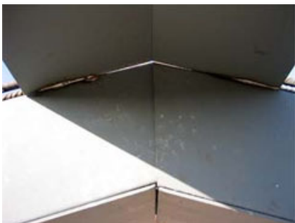
Particolare saldatura capriate con travi TMQ in linea di colmo.
