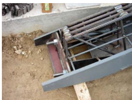
Studio del dettaglio della connessione capriata-pilastro e sua effettiva realizzazione.
