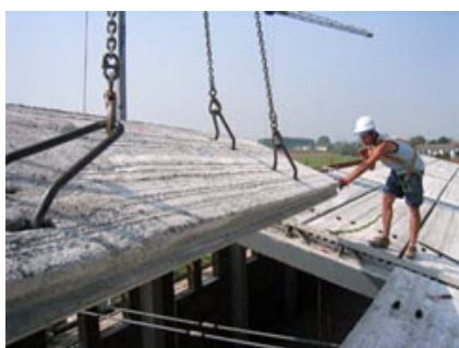
Montaggio solaio alveolare.
