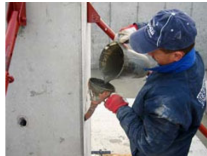
Inghisaggio del pilastro.
