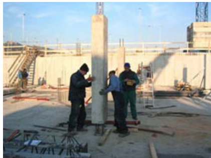
Posizionamento del pilastro.
