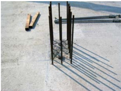
Ferri di ripresa su cui collocare il pilastro.
