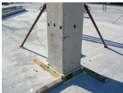
Puntellazione e cassetta dei pilastri.
