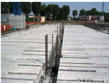
Particolari del solaio alveolare RAP.
