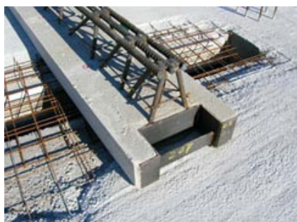
Particolare delle travi miste TLQ.
