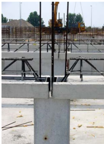
Appoggio delle travi ai pilastri Bautec.
