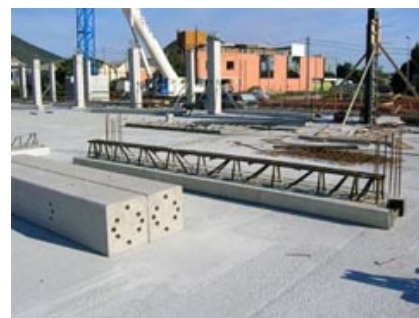
Pilastri Bautec e travi TLQ.
