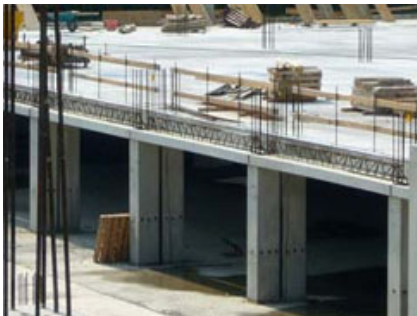
Vista del sistema costruttivo composto da pilastri Bautec, travi TLQ e solaio alveolare RAP.
