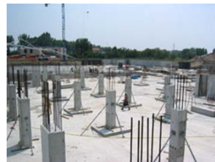
Vista dell'impalcato in fase di realizzazione.
