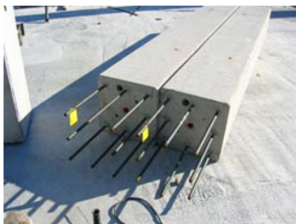
I pilastri Bautec stoccati in cantiere.
