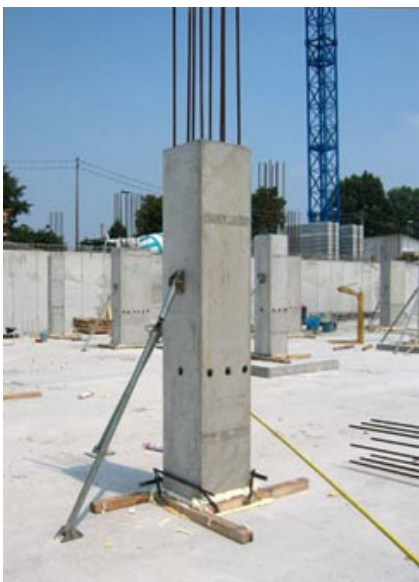
I pilastri Bautec posati.
