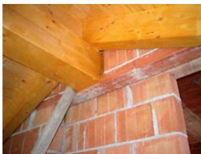
Fig. 6 - Appoggio del colmo della copertura "alta".
