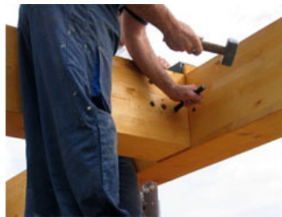
Fig. 8 - Fissaggio dei colmi longitudinali alla piastra.
