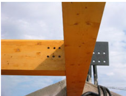
Fig. 6 - Piastra di collegamento dei colmi.
