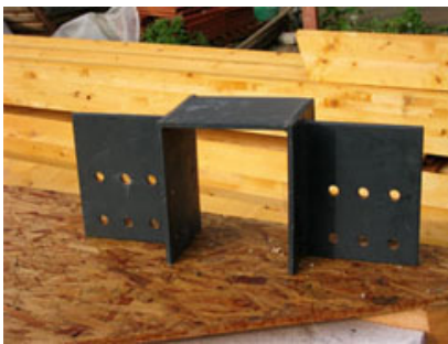
Fig. 6 - Piastra di collegamento dei colmi.
