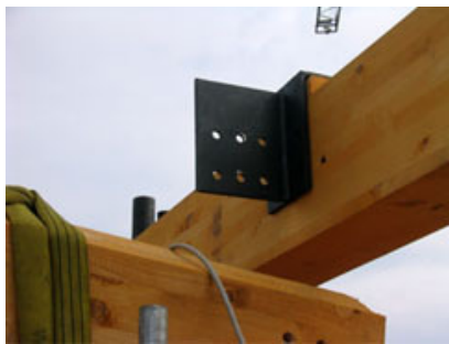
Fig. 7 - Posizionamento dei colmi.
