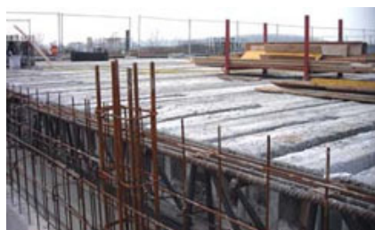
Vista generale del solaio.
