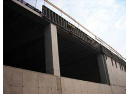
Vista dei casseri fissati con morsetti alle travi di bordo.
