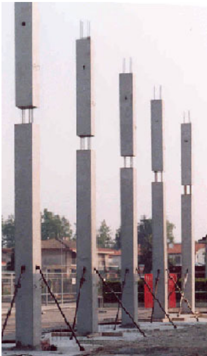
Fig. 2 – Particolare delle strutture verticali ed orizzontali. È possibile notare le armature prima del getto integrativo.
