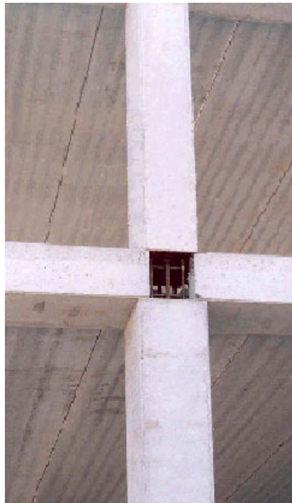
Fig. 2 – Particolare delle strutture verticali ed orizzontali. È possibile notare le armature prima del getto integrativo.
