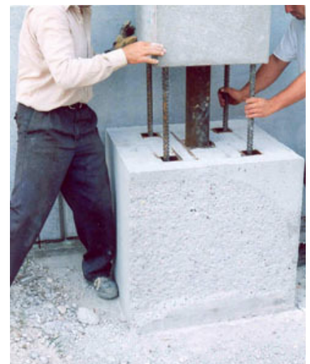
Fig. 7 - Fase di posa in opera di un pilastro.
