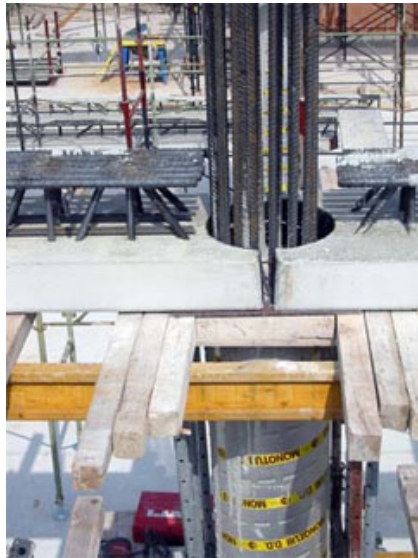
Accostamento di due travi TLQ in corrispondenza di un pilastro.
