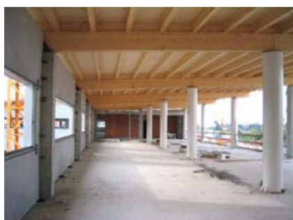
Intradosso della copertura a falda unica.
