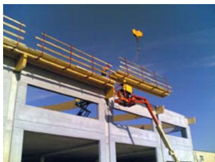
Posa dei pannelli Prepanel® con parapetto.
