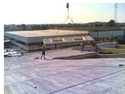
Posa dei pannelli di copertura.
