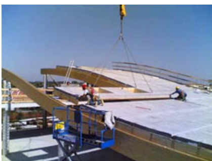
Posa dei pannelli Prepanel® sulle travi curve.
