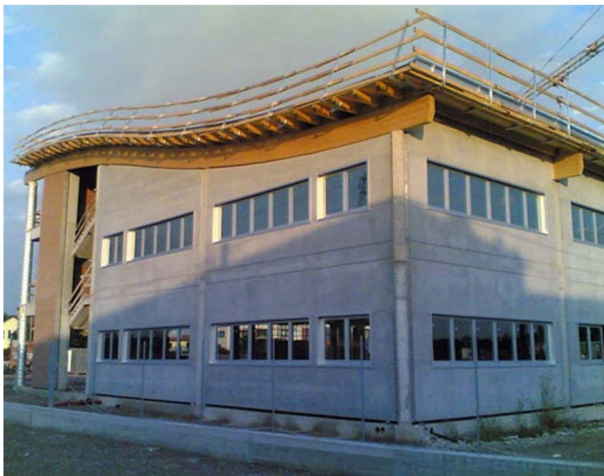
Vista dell'edificio in costruzione.
