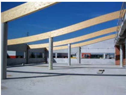
Vista delle travi in legno lamellare curve.
