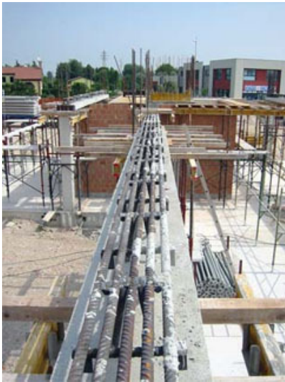
Vista della trave TLQ posata.
