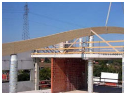
Appoggio della trave in legno lamellare al pilastro.
