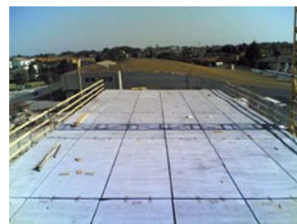
Vista della copertura ad una falda completata.
