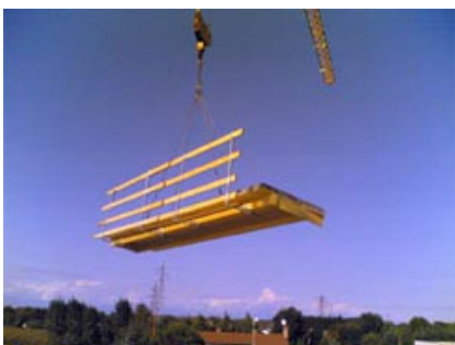
Movimentazione dei pannelli Prepanel® di copertura dotati del parapetto in legno.
