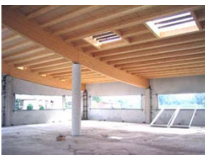
Intradosso della copertura "curva".
