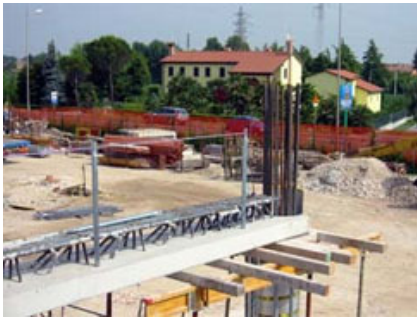
Travi TLQ con inserimento degli elementi del sistema di linee-vita Rurefast 3.
