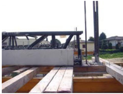
Appoggio della trave TLQ al pilastro.
