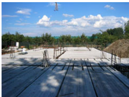
Vista del cantiere.
