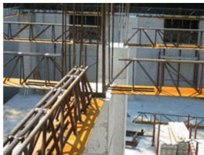
Appoggio delle travi reticolari TAU PLUS che sosterranno i pannelli di solaio alveolare RAP del piano interrato sui pilastri in c.a. eseguiti in opera.
