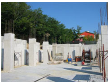
Le strutture portanti verticali.
