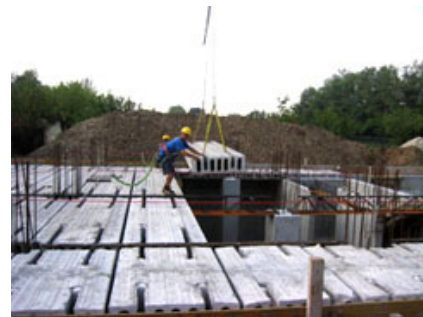
Posa dei pannelli di solaio alveolare RAP.
