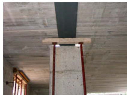
Intradosso dell'impalcato prima del getto.
