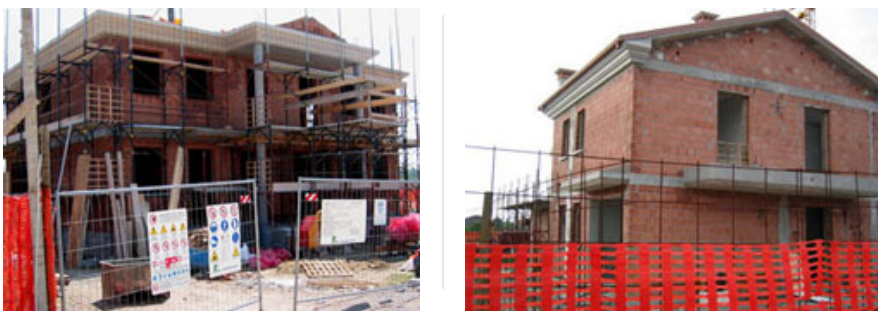
Vista di due cantieri in cui trova impiego il sistema di muratura armata.
