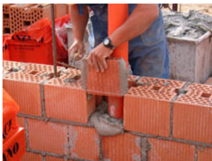
Fase di posa dei blocchi in laterizio.
