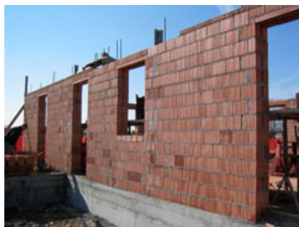
Edificio in fase di realizzazione.
