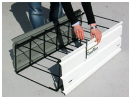
Accostamento dei pannelli, con aggancio mediante apposite forchettoni. Si notino le fessure da eseguire in opera nella parte inferiore.
