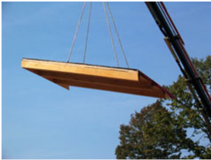
Fase di movimentazione del pannello Preconnect.
