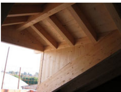
Vista interna dell'abbaino finito.
