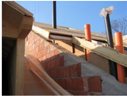
Struttura Preconnect posata.
