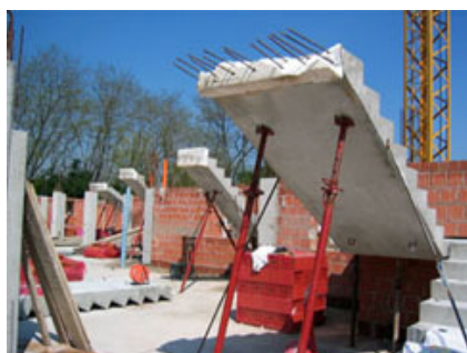
Particolare per la posa delle scale prefabbricate.
