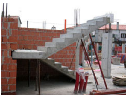
Vista del pianerottolo che collega le due rampe di scale.
