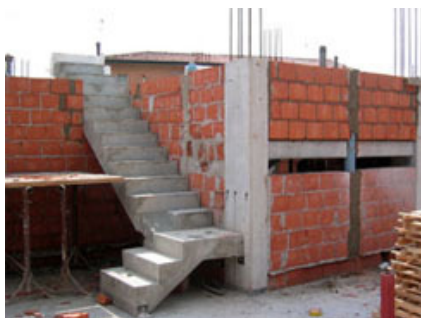
Rampa di scale prefabbricata.
