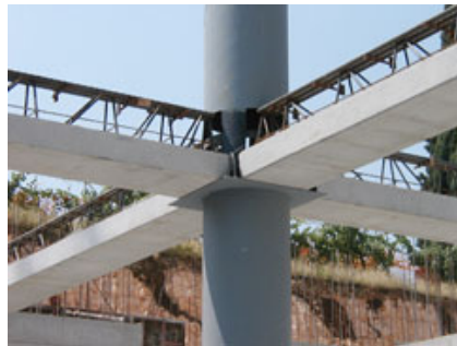
Fig. 3 – Le travi reticolari TLQ formano un graticcio su cui poggiare il solaio alveolare.
