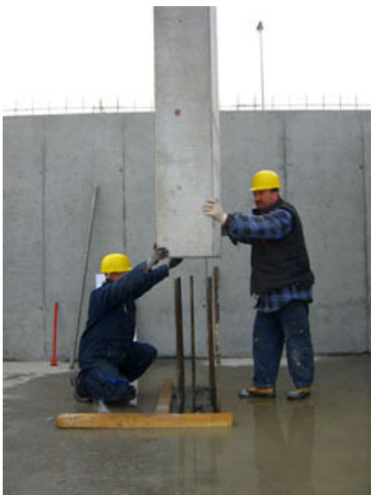
Fig. 6 - Posa dei pilastri sui ferri di chiamata delle fondazioni.
