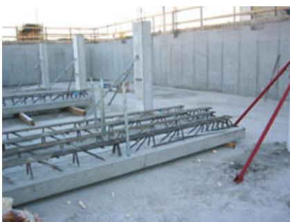
Fig. 9 - Aste della linea vita posate nelle travi accatastate a terra.
