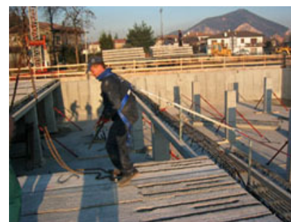
Fig. 11 - L'operatore è imbracato e agganciato alla fune.
