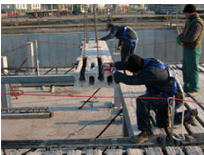
Fig. 12 - Fase di posa del solaio RAP (lastra speciale da L=60 cm).
