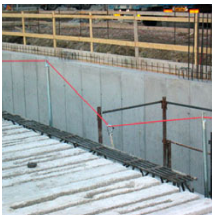
Fig. 15 - Simulazione di caduta dell'operatore. Si noti la massima deformazione della fune sottoposta al carico dell'operatore.
