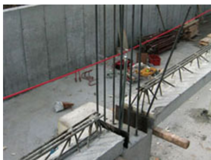
Fig. 10 - Inserimento della fune sintetica nel paletto fissato nelle strutture portanti verticali.
