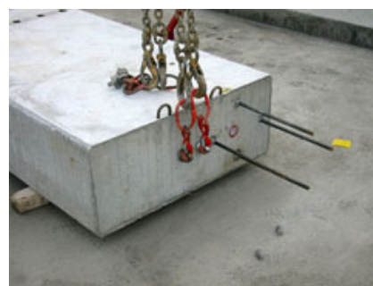
Fig. 5 - Boccola inserita in un pilastro, posizionata tra i ferri di ripresa e le boccole di sollevamento.
