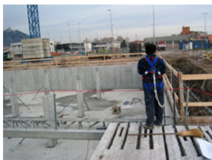
Fig. 13 - L'operatore può muoversi liberamente lungo la direttrice di posa, pur essendo collegato con l'imbracatura alla linea vita.
