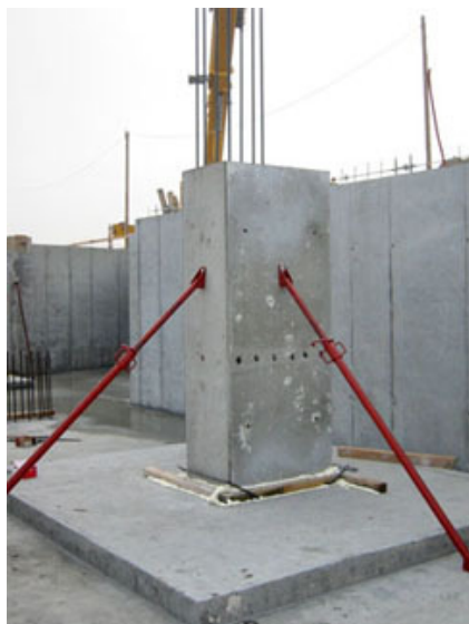
Fig. 7 - Pilastro in fase di maturazione nell'inghisaggio.
