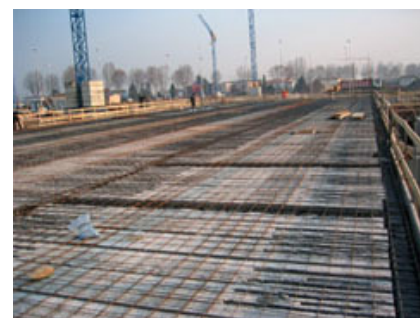
Fig. 14 - Vista dell'impalcato posato.
