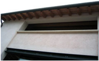
Fig. 7 - Le teste sporgenti dei travetti.
