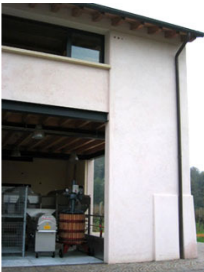
Fig. 2 - Intonaco completamente realizzato a mano.
