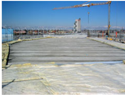
Fig. 8 - Vista del solaio alveolare.
