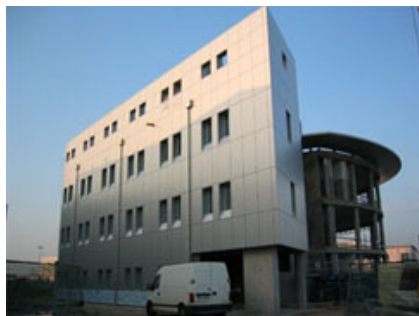
Fig. 16 - Vista d'insieme della struttura in doppia lastra rivestita in pannelli d'alluminio Alubond.
