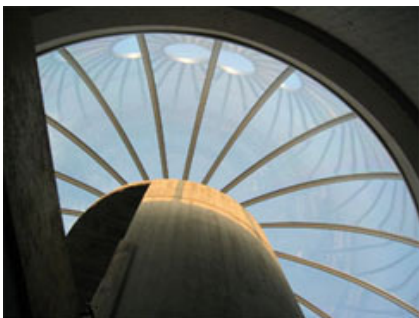
Fig. 12 - Particolare della cupola in vetro che consente l'illuminazione naturale dell'edificio.
