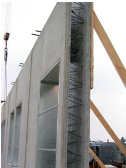
Fig. 17 - Particolare di un pannello con foro finestra.
