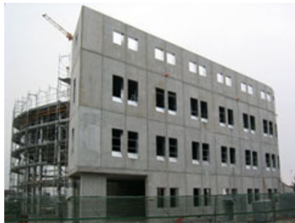
Fig. 10 - Vista della struttura in doppia lastra terminata.
