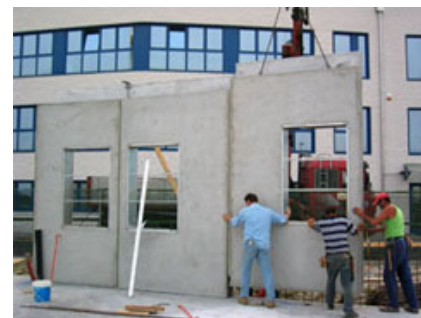
Fig. 6 - Sollevamento e movimentazione di un pannello in doppia lastra.
