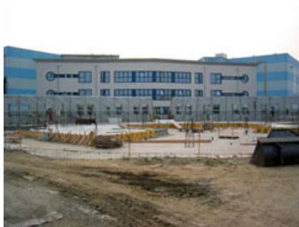
Fig. 4 - Vista del cantiere.
