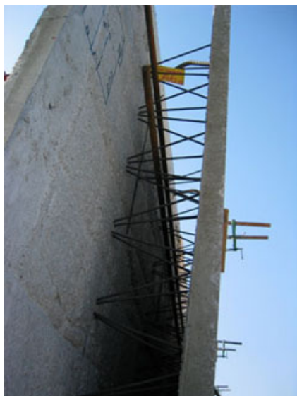
Fig. 18 - Vista del traliccio interno ai due elementi in c.a. che costituiscono la doppia lastra.
