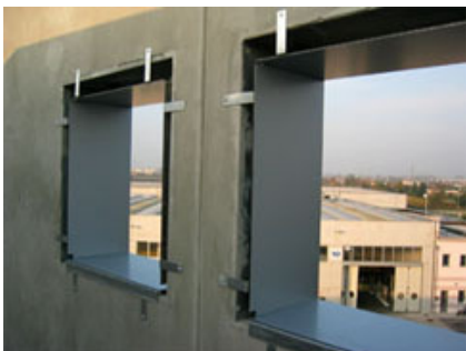
Fig. 15 - Sistema di inserimento delle finestre.
