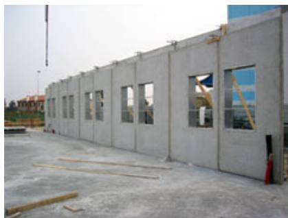
Fig. 5 - Posa degli elementi in doppia lastra del piano terra.
