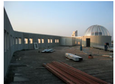
Fig. 11 - Terrazza ricavata all'ultimo piano dell'edificio.
