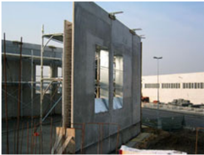
Fig. 7 - Pannello in doppia lastra con foro finestra dotato di svasatura.
