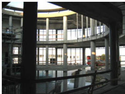
Fig. 13 - Vista della zona circolare dell'edificio.
