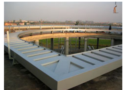
Fig. 14 - Particolare della struttura in alluminio della zona circolare.
