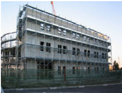
Fig. 9 - Posa dell'ultimo corso di pannelli in doppia lastra.
