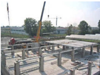
Fig. 6 - Vista del cantiere.
