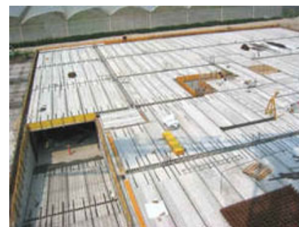
Fig. 5 - Vista del primo impalcato realizzato con solai alveolari e travi TLQ.
