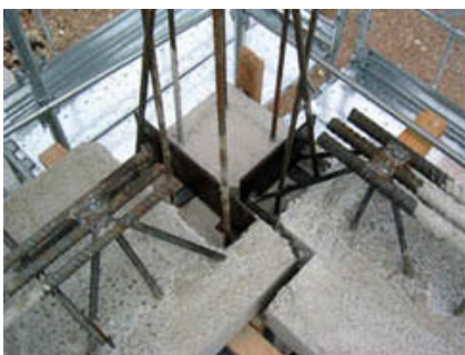
Fig. 3 - Appoggio delle travi reticolari sulle strutture perimetrali.
