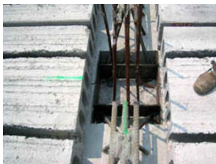
Fig. 4 - Appoggio del solaio alveolare sulle travi reticolari.
