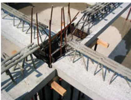
Fig. 2 - Incrocio delle travi reticolari.
