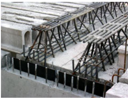
Fig. 6 - Appoggio del solaio alveolare alle travi reticolari.
