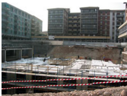
Fig. 8 - Vista del cantiere.
