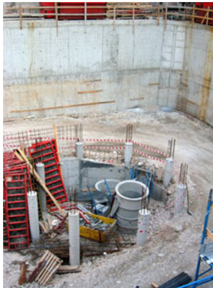
Fig. 4 - Struttura per la realizzazione della rampa di accesso al parcheggio interrato.
