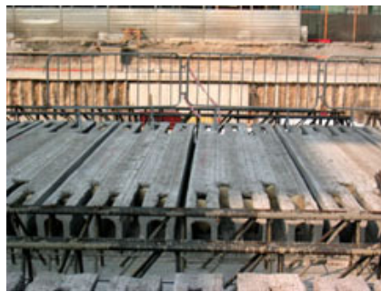
Fig. 7 - Particolare dei pannelli di solaio alveolare.
