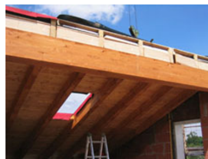
Fig. 4 - Vista della stratigrafia del pannello Preconnect.
