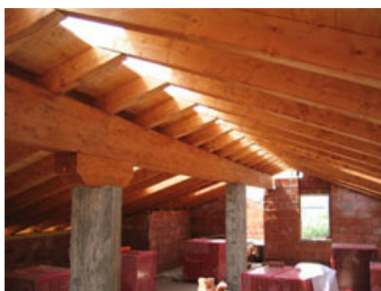
Fig. 2 - Il colmo della copertura è costituito dall'unione a vista dei travetti combacianti in corrispondenza delle due falde.
