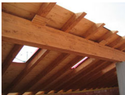
Fig. 1 - Appoggio dei pannelli sulla terzera.
