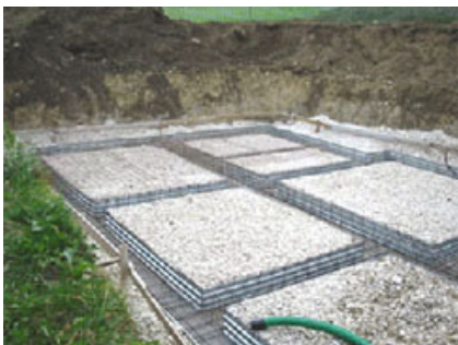
Vista d'insieme del cantiere.
