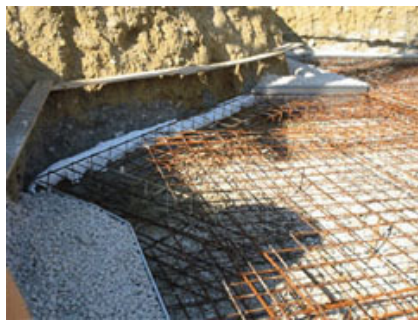
Fondazione a platea con utilizzo dei pannelli FlashFond®.
