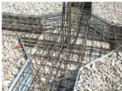
Particolare per la realizzazione di un plinto.
