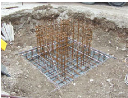
Esempio di realizzazione di un plinto.
