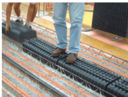
Fig. 3 - Calpestabilità del solaio uniSOL® con elementi geoSOL®.
