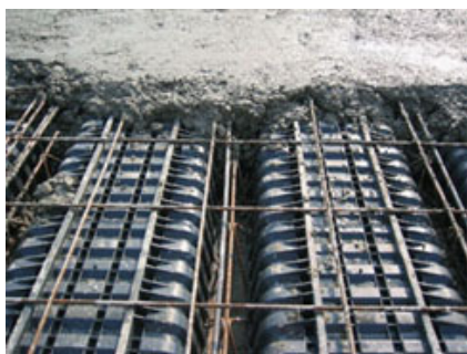
Fig. 2 - Elementi di geoSOL® durante la fase di getto del calcestruzzo.
