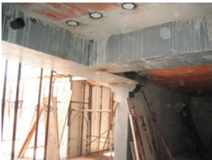
Fig. 8 - Una volta realizzati i muri del nuovo interrato la maglia strutturale composta di micropali è stata smantellata. Sul soffitto dell'interrato si possono notare i micropali tagliati a fiamma ossidrica.
