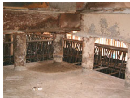
Fig. 7 - Micropali e travi reticolari.
