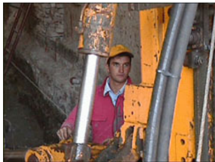
Fig. 3 - Alberto Nardo durante lo scavo del piano interrato del palazzo.
