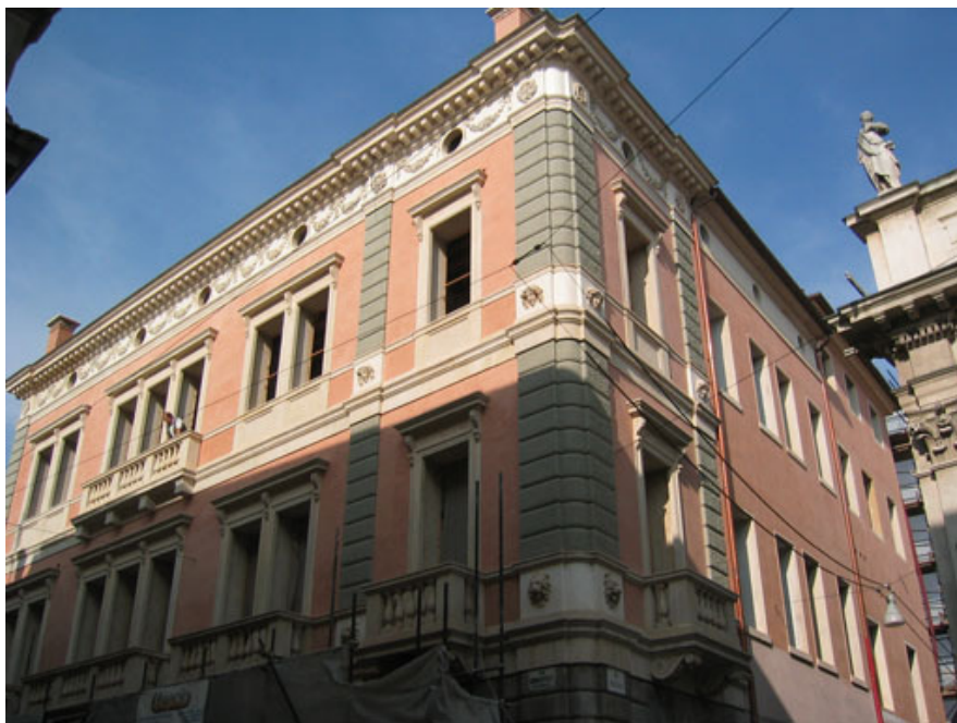
Fig. 1 - Facciate principali del palazzo Deodara.
