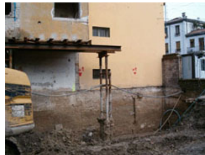
Fig. 4 - Vista esterna della struttura su micropali.
