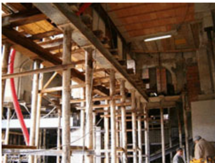
Fig. 2 - Struttura composta da micropali per sostenere il peso dell'edificio esistente.
