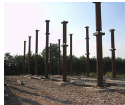
Fig. 4 – Vista dei pilastri pluripiano.
