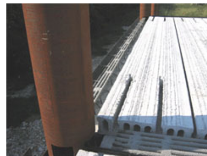
Fig. 7 – Particolare del nodo pilastro, travi reticolari e solaio alveolare.
