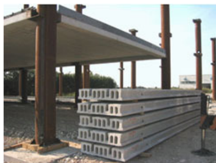
Fig. 8 – Pannelli di solaio alveolare RAP.
