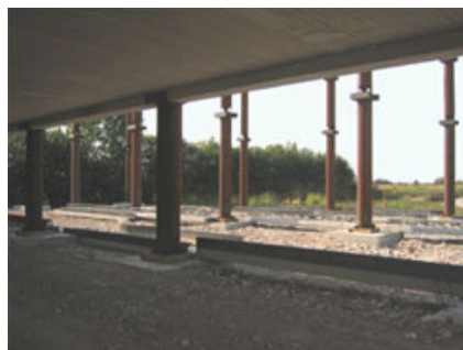
Fig. 5 – Realizzazione del primo solaio intermedio.
