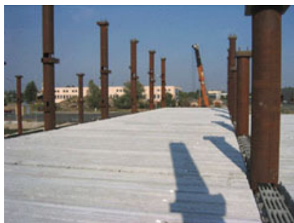
Fig. 6 – Solaio montato a secco, prima del getto integrativo.
