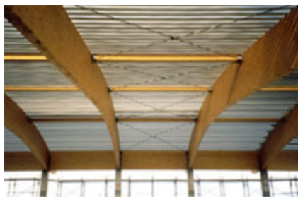
Fig. 9 - Tiranti che fungono da controvento.
