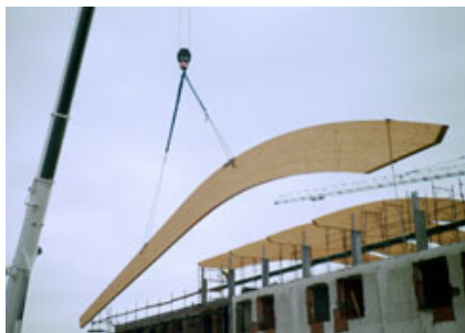
Fasi di montaggio delle travi principali.
