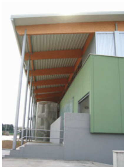
Fig. 11 – Particolare della scala a chiocciola esterna.
