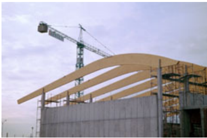
Fig. 5 – Travi in lamellare che costituiscono la struttura della copertura del palazzetto.
