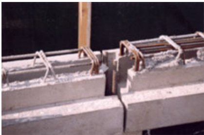
Fig. 6 - Particolari del nodo travi-pilastri di bordo.
