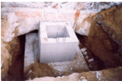
Fig. 3 – Plinto di fondazione.
