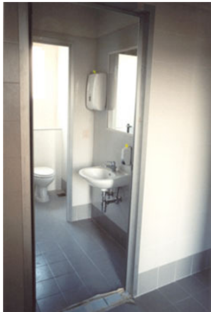
Fig. 13 – Finitura interna di una cellula bagno.
