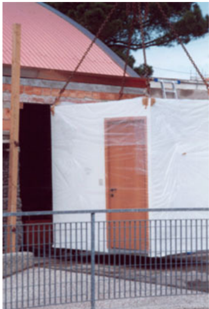
Fig. 12 – Fase di posa di una cellula bagno prefabbricata.
