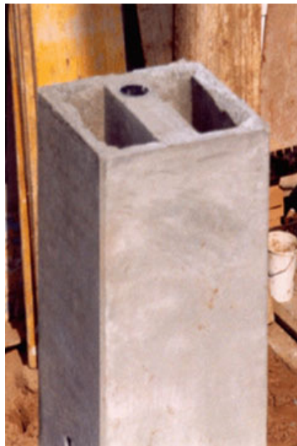
Fig. 5 – Pilastro centrale provvisto di tasche e di foro per il perno di centraggio.
