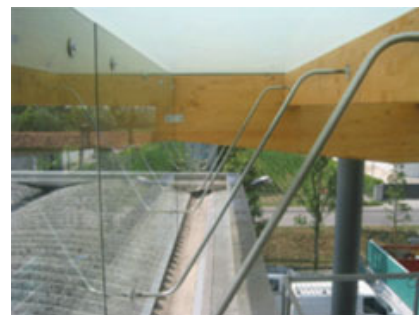
Fig. 12 – Particolare delle chiusure del portico con pannelli di vetro.
