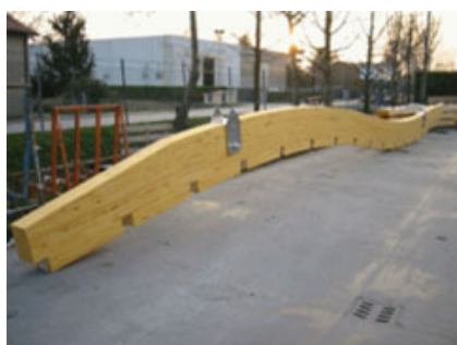
Fig. 4 – Trave primaria curva. Si notino le tasche che alloggeranno i travetti e le piastre metalliche per l'ancoraggio ai pilastri.
