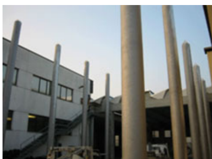
Fig. 3 – Pilastrini di sostegno della struttura in legno.
